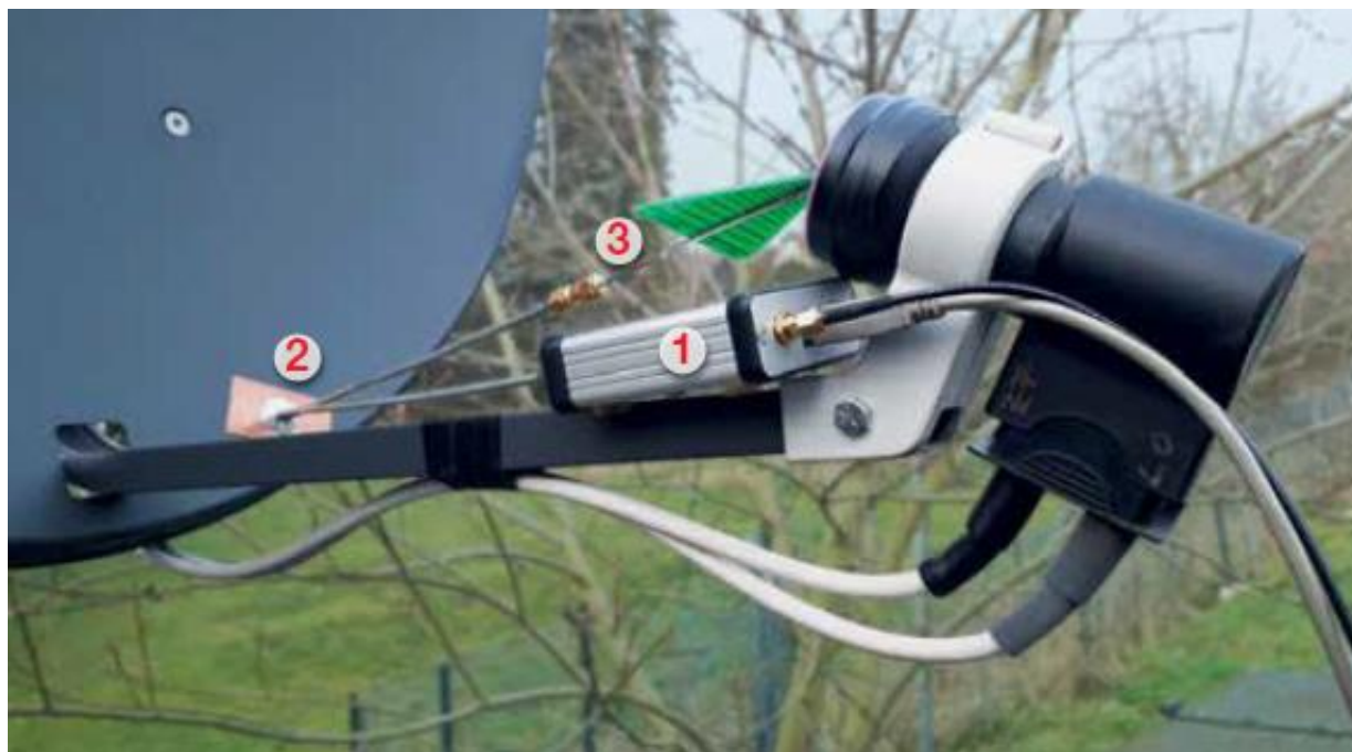
Fot. 8.15. Konfiguracja służąca do strojenia filtra z wykorzystaniem LNB od QO-100; 1 – GPSDO, 2 – filtr, 3 – antena pomiarowa (patrz fot. 8.17)
